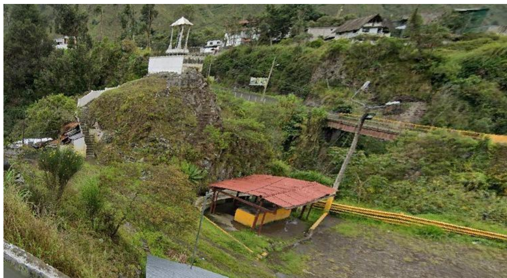
Imagen 03. Construcciones Existentes en la Plazoleta
