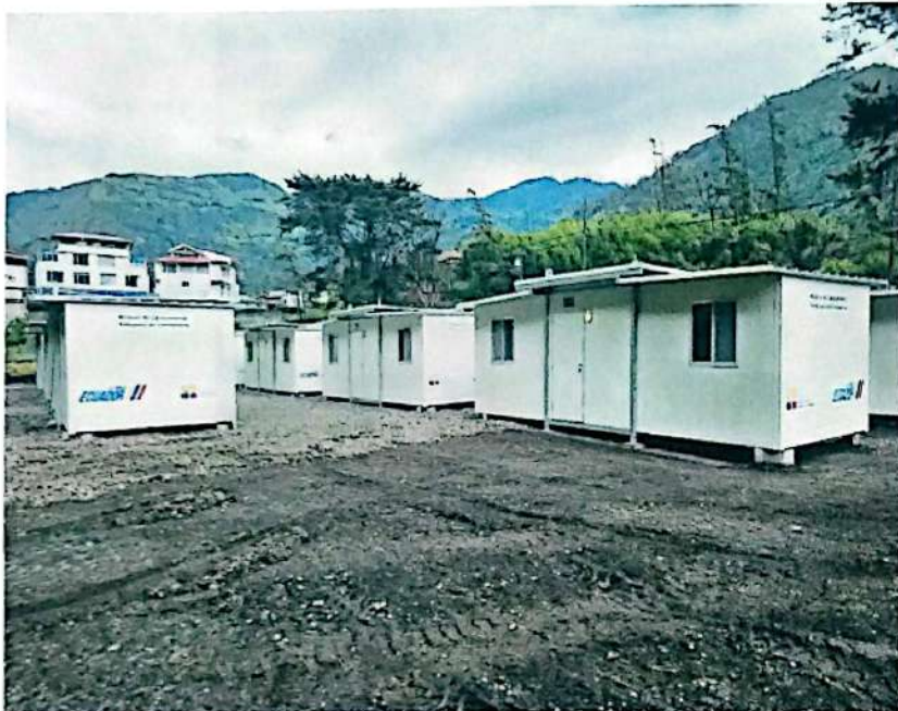
Foto 3.- Alojamientos Temporales Unifamiliares instalados en el Complejo Turístico de Santa Ana
