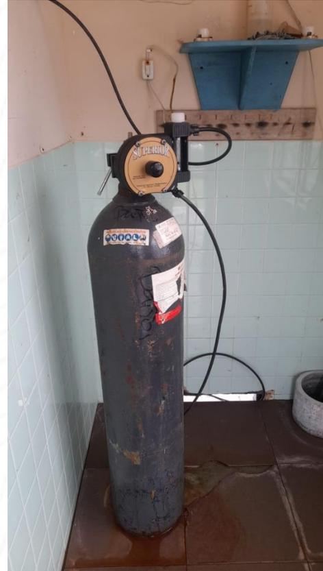
Se realizaron pruebas hidrostáticas a mas de 30 cilindros de clorogas, con el propósito de evitar fugas y desperdicio de esta sustancia; brindando seguridad dentro de la planta de agua potable y servicio de calidad a la población baneña con agua sin contaminantes.
